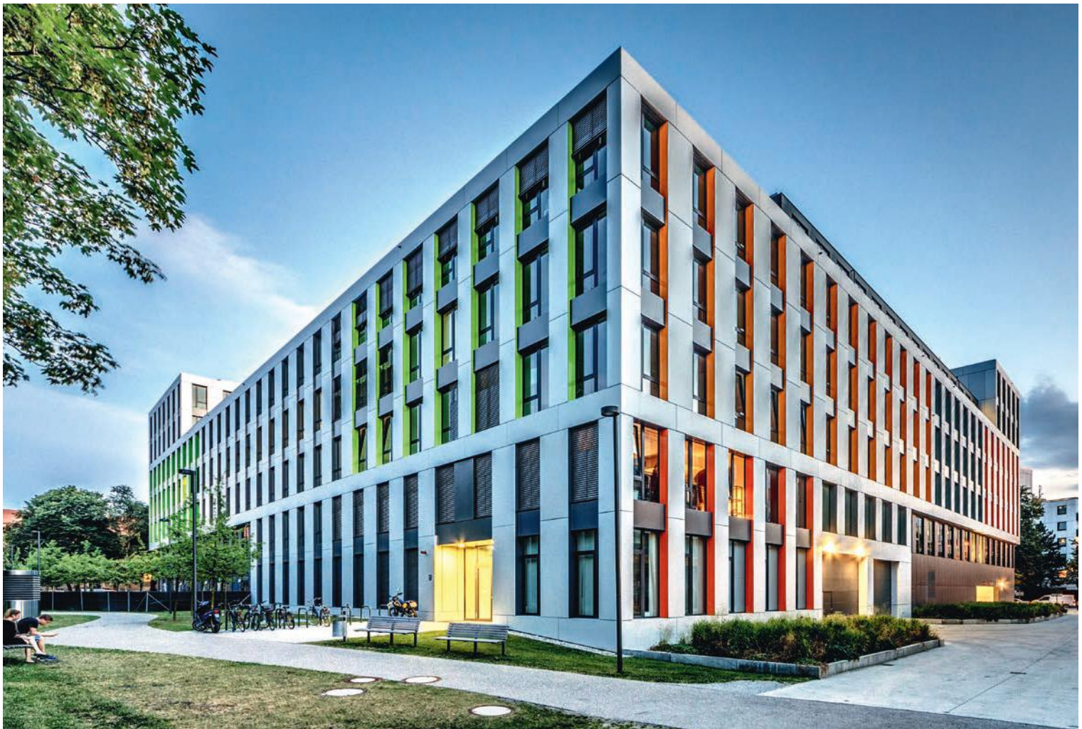
Das Büro- und Geschäftshaus „Smarthouse“ in München erfüllt höchste Ansprüche an die Nachhaltigkeit, dokumentiert durch die beste DGNB Zertifizierung in Platin.
